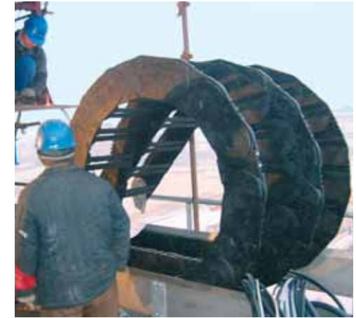
E4拖链800系列安装在易格斯钢制导向槽中
