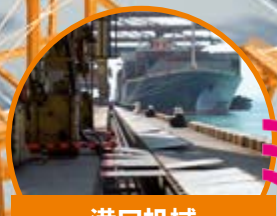
港口机械 岸桥(STS) 大车供电
